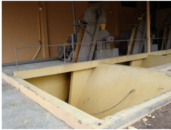
Figura 17 Tolva de lagar sin protecciones de seguridad
