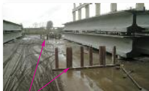
Peines para el acopio de vigas peraltadas
